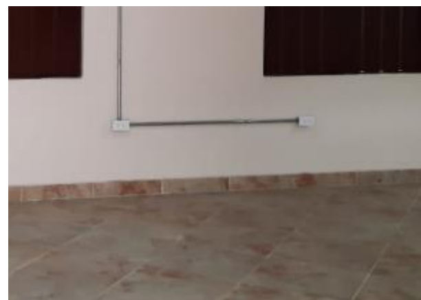
Foto 10. Instalación de tomacorrientes
