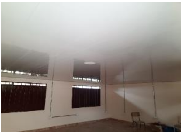
Foto 7. Instalación de cielo raso en aula de sistemas
