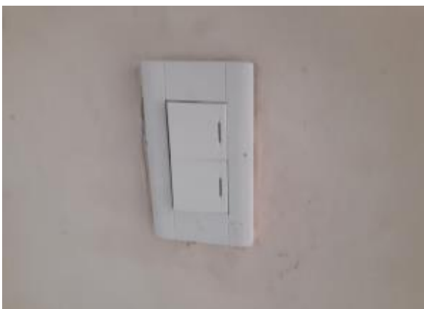
Foto 11. Instalación de interruptores
