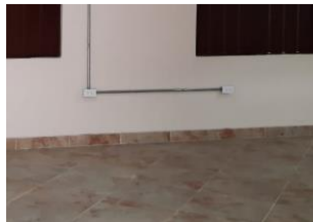
Foto 12. Instalación de tomacorrientes
