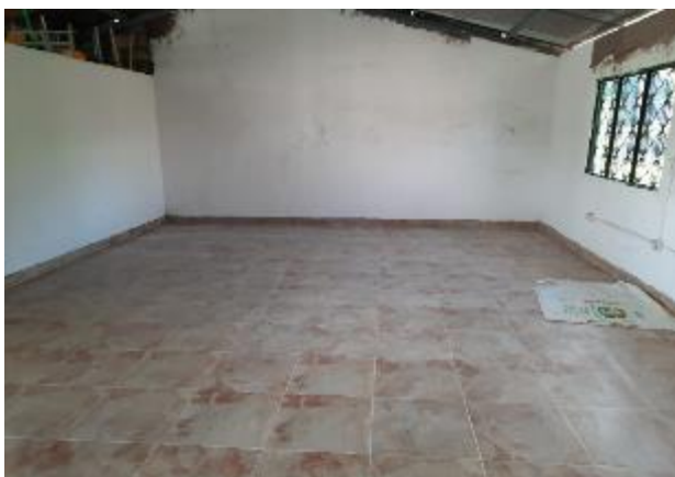
Foto 1. Instalación de enchape de piso en aula 1
