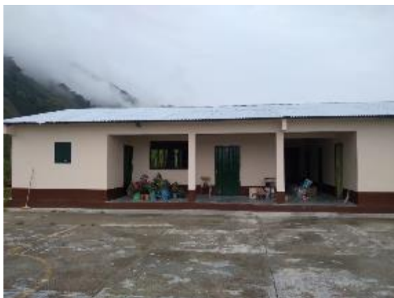
Foto 4. Pintura exterior en muros
