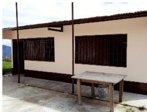
Foto 6. Pintura en carpintería metálica
