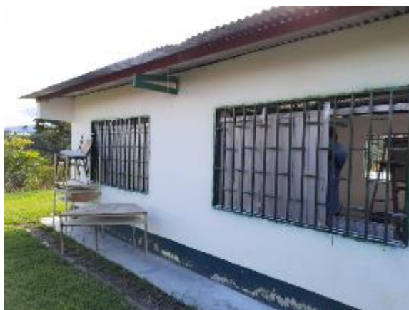
Foto 2. Instalación de ventana en lámina llena
