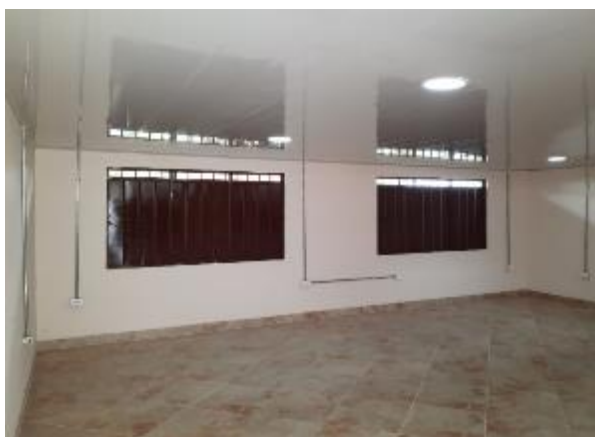
Foto 9. Instalación de tubería EMT para red eléctrica
